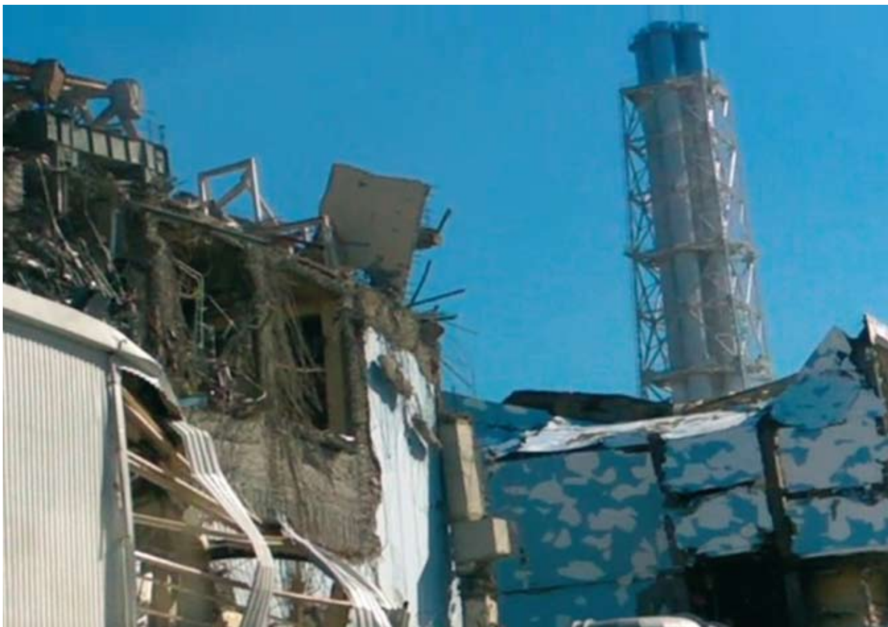
Devastazione edifici ausiliari. Le unità 3 ( sinistra ) e 4 ( destra ) della centrale di Fukushima fotografate il 18 marzo. Entrambe mostrano i gravi danni provocati dalle esplosioni interne agli edifici. A fronte, l'interno del primo piano dell'unità 3 fotografato da un robot il 17 aprile.
